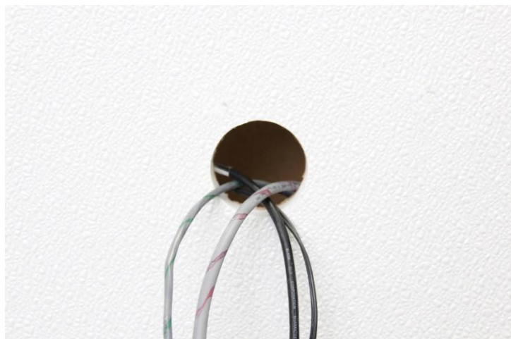
Figure 4 - Hole for TIU Wiring
